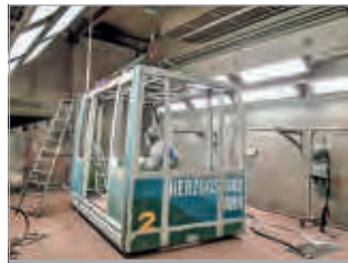
Préparation de la protection anti-corrosion
