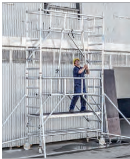
1. Mettre en place le garde-corps avancé
