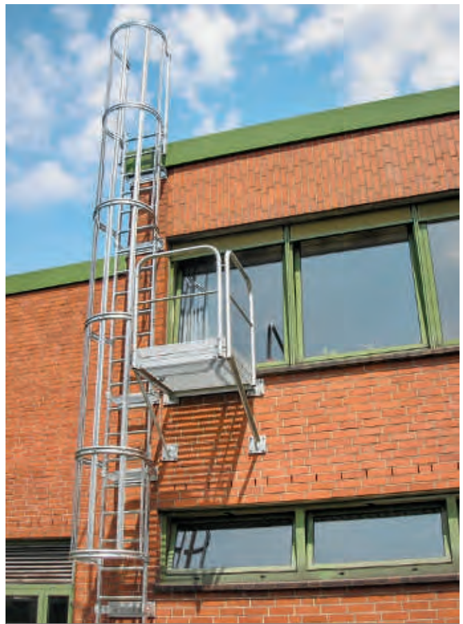
Installation d'échelle de secours à volée simple avec podium
