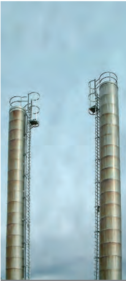
Installation d'échelle à crinoline avec protection anti-chute pour cheminées
