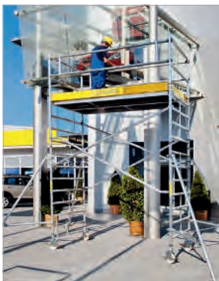
Les échafaudages mobiles sans traverse existent en deux largeurs (0,75 m et 1,35 m) ils peuvent être montés jusqu'à 10,40 m. La hauteur sans traverse peut atteindre 1,90 m (au milieu).
