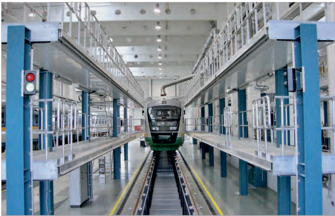
Poste de travail au niveau du toit avec deux niveaux
