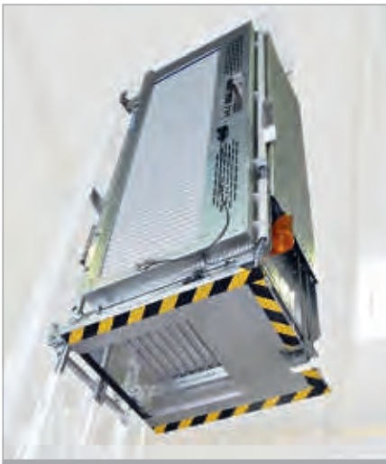
Ascenseur de service (NCV/CCV)
