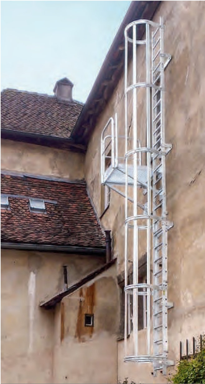
Installation d'échelle à volée simple avec podium pour sortie de secours
