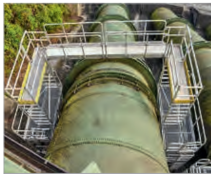
Installation d'échafaudages de travail pour la maintenance de tuyaux de descente dans les centrales hydroélectriques
