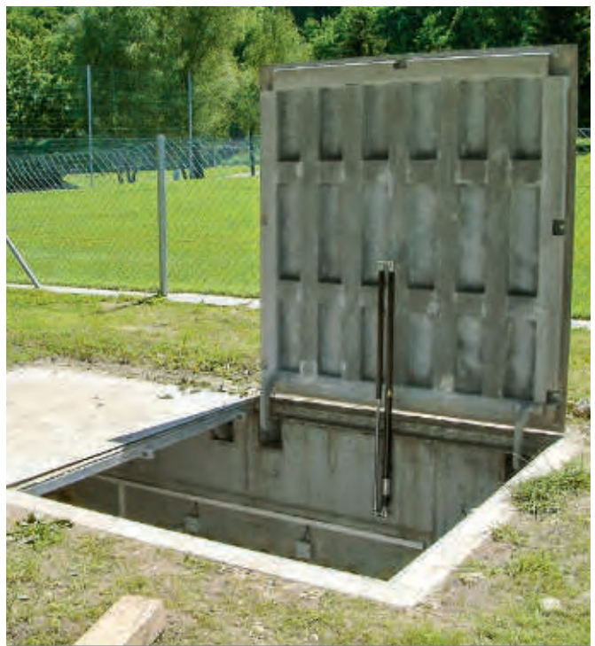
Couvercle de puits avec amortisseur à gaz comprimé
