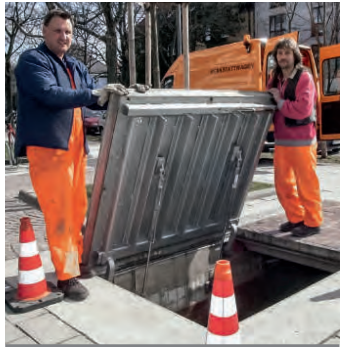
Couvercle de puits avec amortisseur à gaz comprimé
