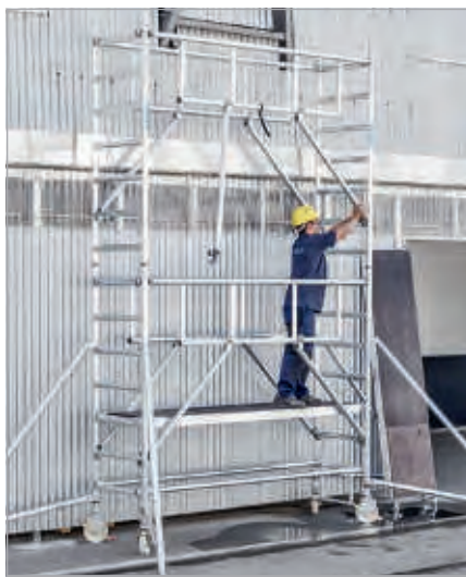
2. Fixer le garde-corps aux échelons
