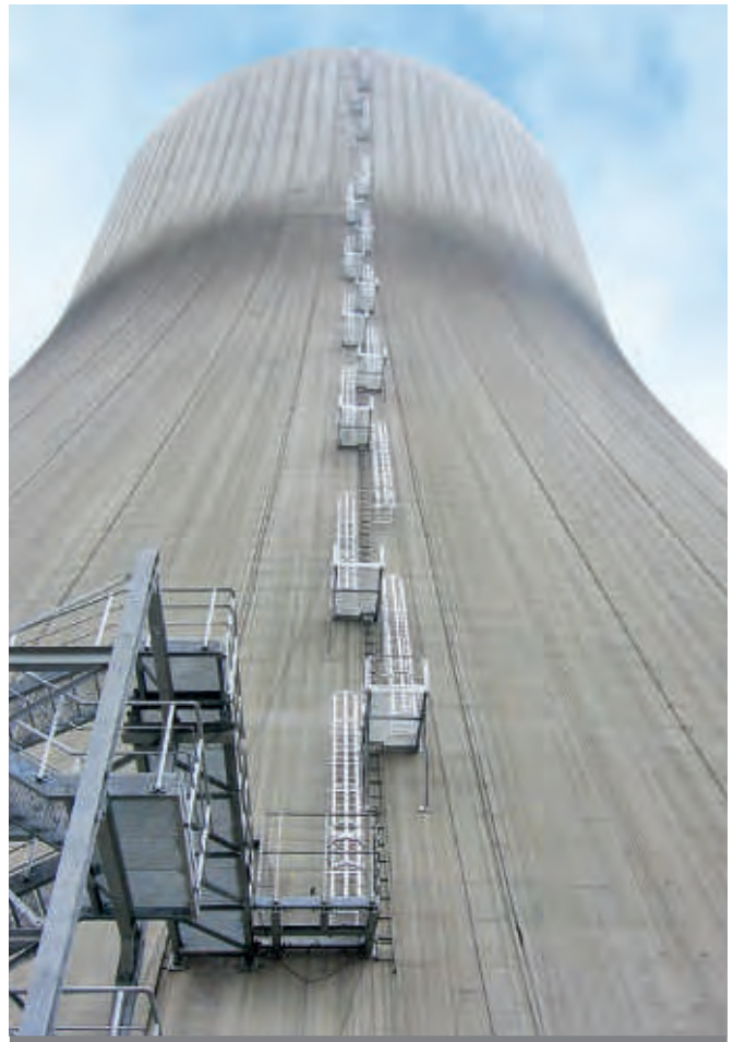
Installation d'échelles à crinoline sur une tour de refroidissement
