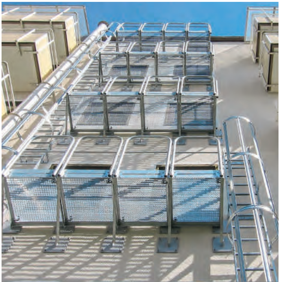
Installation d'échelle de secours pour immeuble
