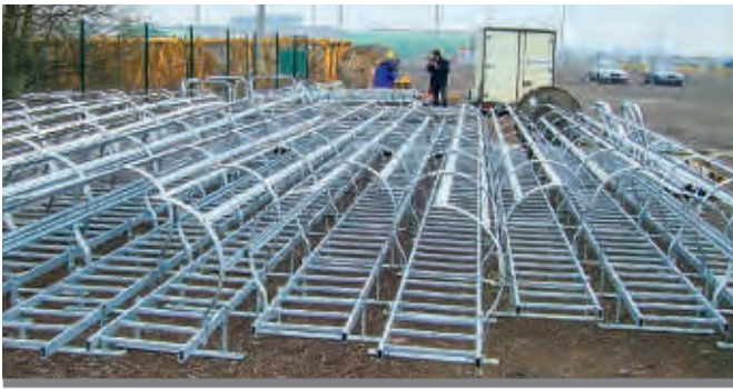
Installations d'échelles à crinoline à volée simple Echelles prémontées avec protection dorsale avant le montage
