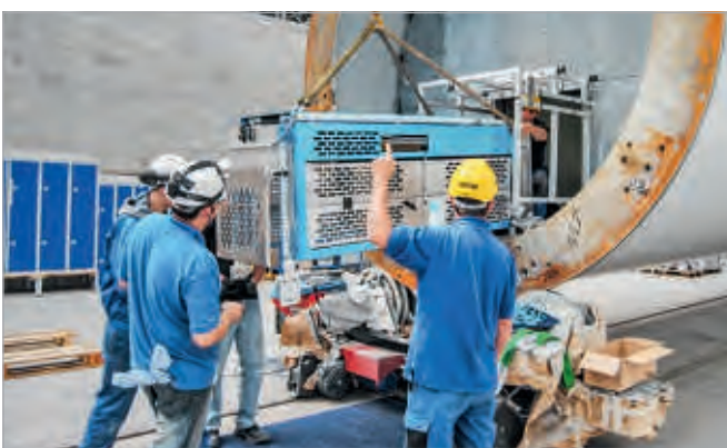
Montage complet sur site
