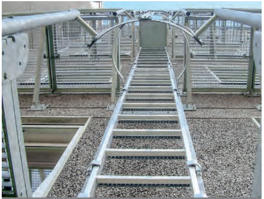
Installation d'échelle de secours pour immeuble
