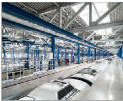
Poste de travail stationnaire au niveau du toit avec une longueur d'env. 1300 m pour 3 voies
