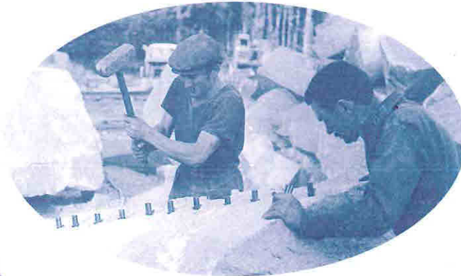
Tranchage d'un bloc de granit avec des coins de 22 x 115
