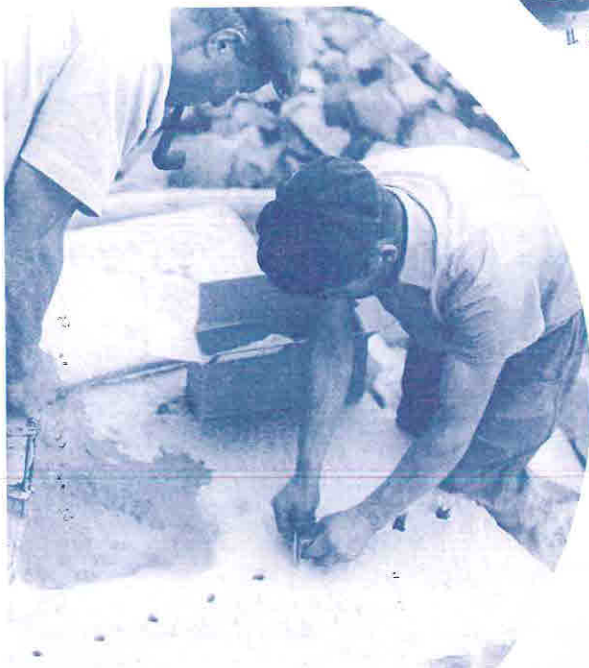
Tranchage d'un bloc de granit avec des coins de 22 x 115
